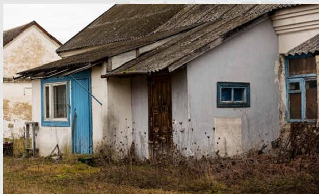
Logement locatif avant rénovation.
